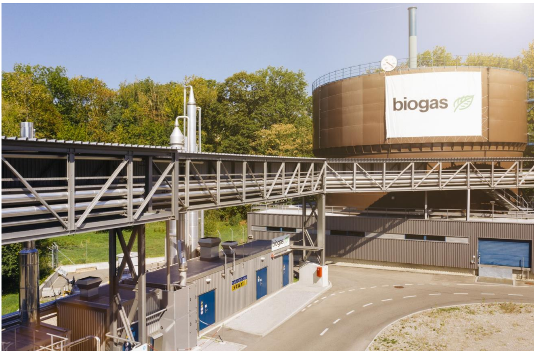
Abbildung 2: Aufnahme Biogas-Aufbereitungsanlage (GAA) mit Gasometer (GAS) auf dem Gelände des Klärwerk Werdhölzli.
